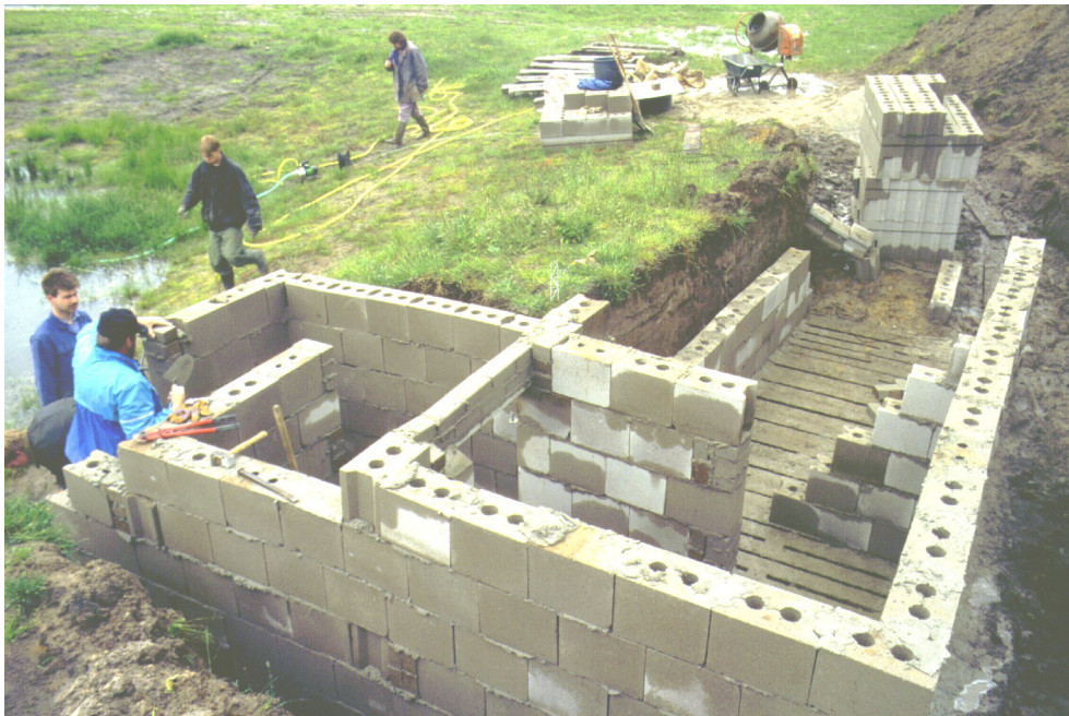
Aanleg van een vleermuiskelder.
